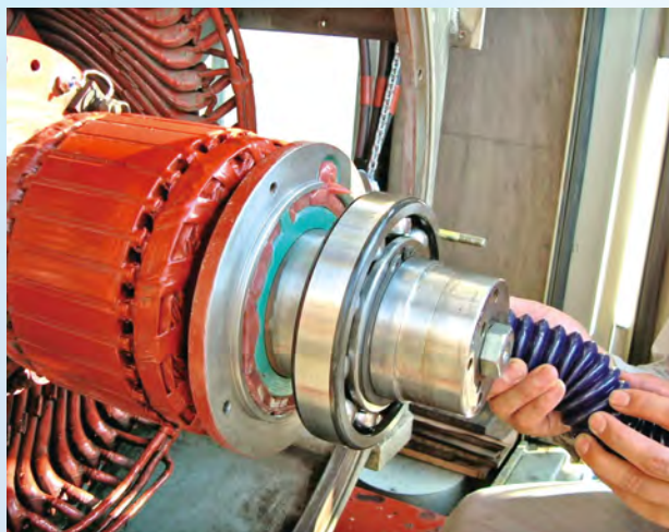
ベアリング交換作業
